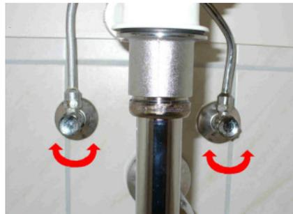
Drehen Sie diese Ventile zunächst **ganz zu** und anschließend wieder **fast ganz auf**. Somit bleiben die Ventile gängig.
